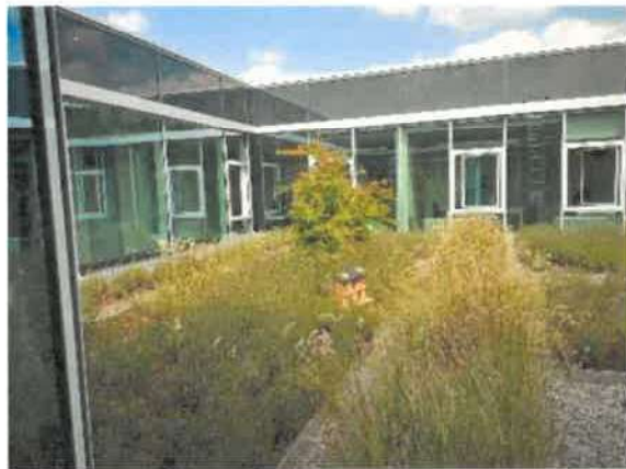
Begrünter Dachgarten LHW
